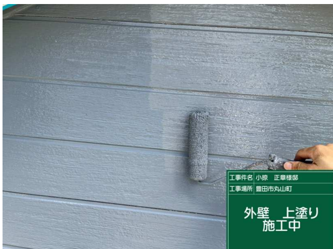
17 外壁 上塗り 施工中
