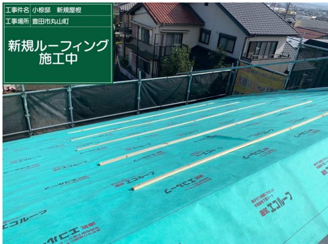
43 屋根 ルーフィング貼り 施工中
