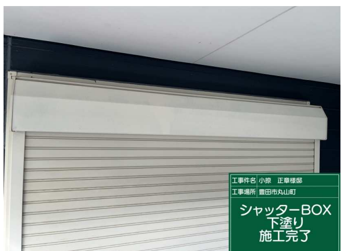
30 シャッターBOX 下塗り 施工完了
