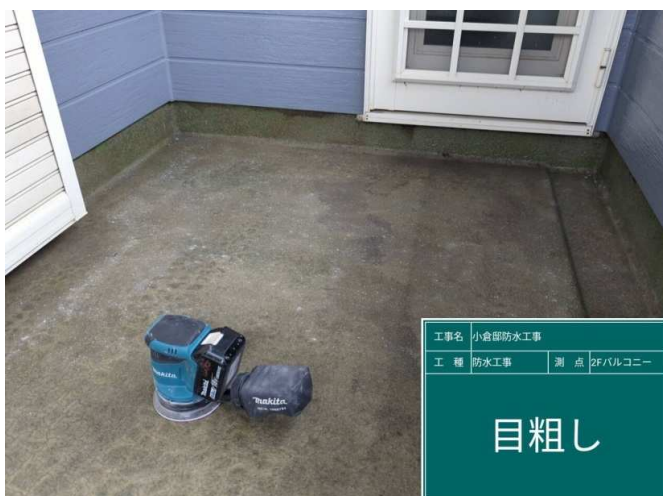
35 防水 目荒らし 施工中
