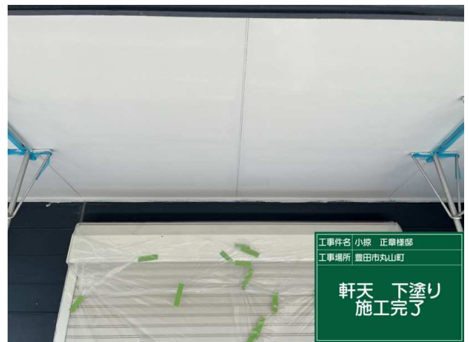
10 軒天 下塗り 施工完了
