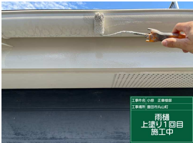
25 雨樋 上塗り 1回目 施工中
