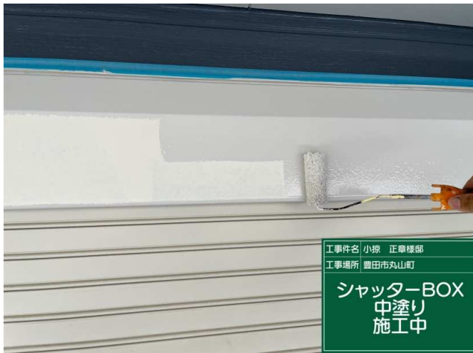
31 シャッターBOX 中塗り 施工中
