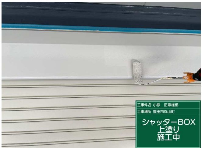
33 シャッターBOX 上塗り 施工中
