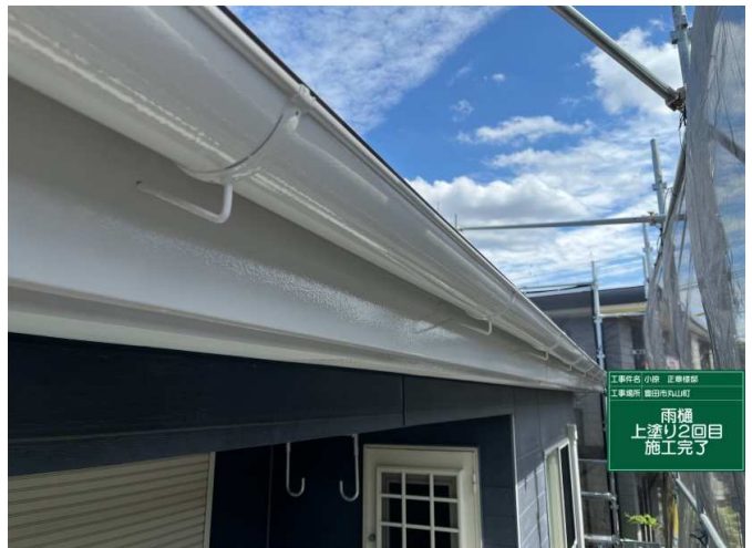
28 雨樋 上塗り 2回目 施工完了
