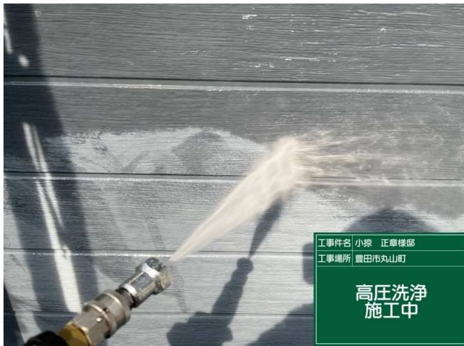
1 高圧洗浄 施工中
