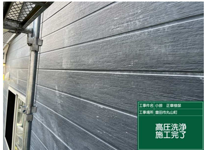
2 高圧洗浄 施工完了
