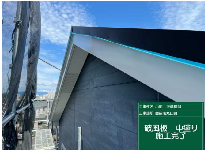
22 破風板 中塗り 施工完了
