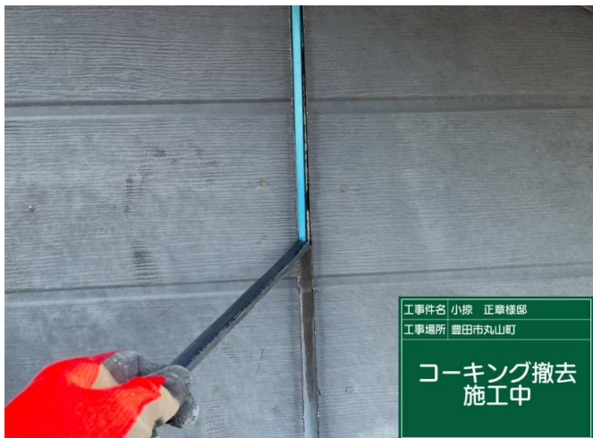
3 既設コーキング撤去 施工中
