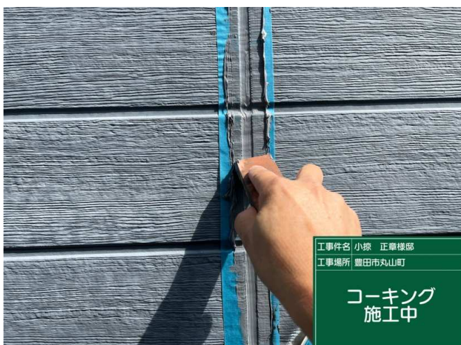
5 コーキング 施工中
