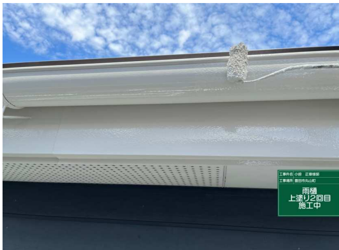
27 雨樋 上塗り 2回目 施工中
