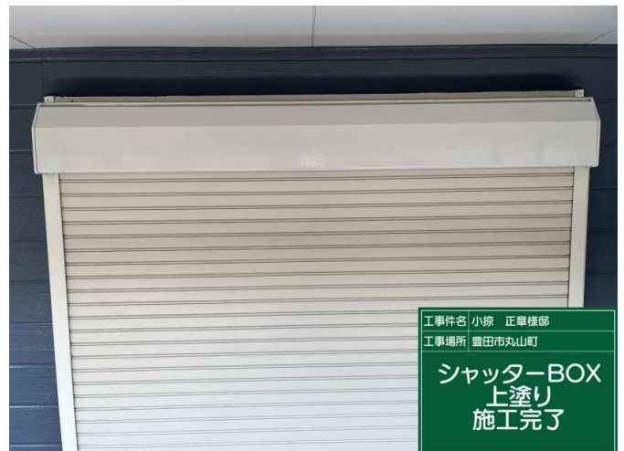
34 シャッターBOX 上塗り 施工完了
