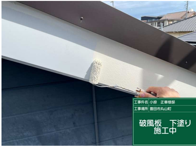
19 破風板 下塗り 施工中
