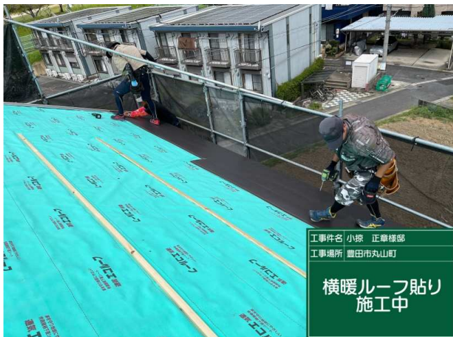
45 横暖ルーフ S貼り 施工中
