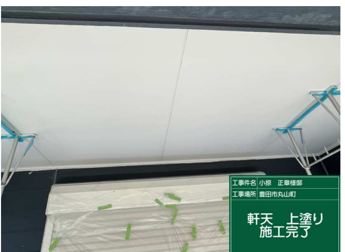
12 軒天 上塗り 施工完了
