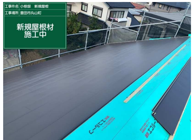
46 横暖ルーフ S貼り 施工中
