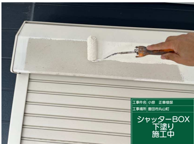
29 シャッターBOX 下塗り 施工中
