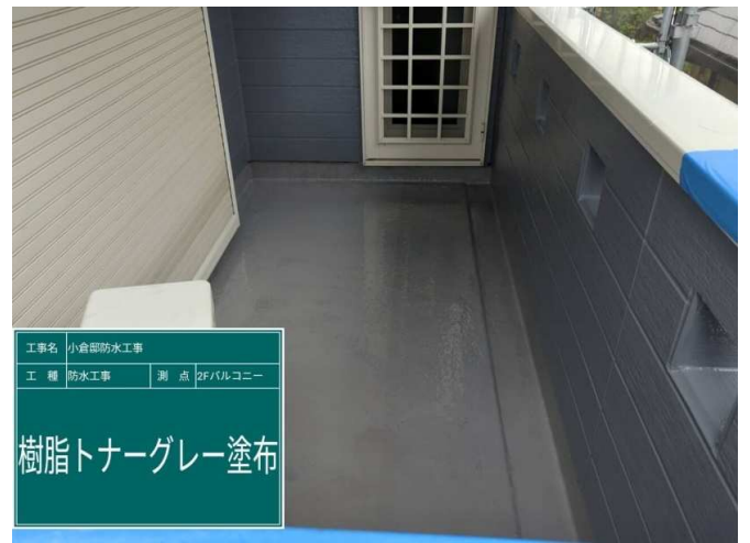
40 防水 樹脂トナーグレー 施工完了
