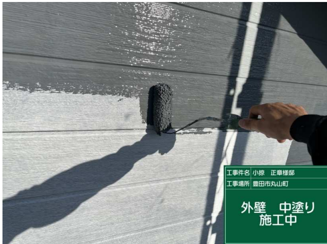
15 外壁 中塗り 施工中
