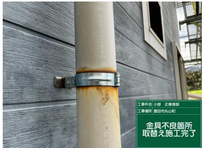
8 配管金具不良箇所 取替え施工完了
