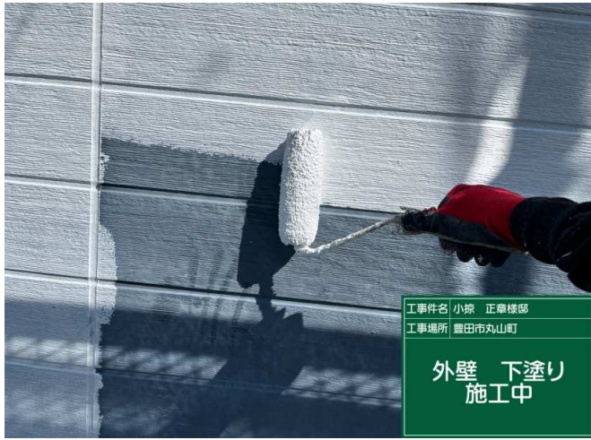
13 外壁 下塗り 施工中
