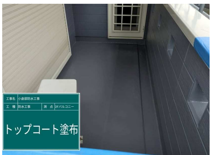
42 防水 トップコート 施工完了
