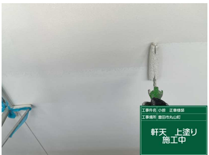
11 軒天 上塗り 施工中
