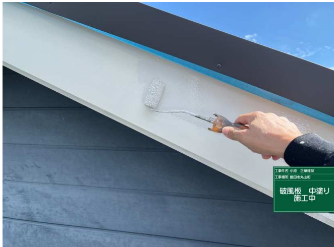
21 破風板 中塗り 施工中
