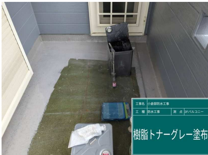
39 防水 樹脂トナーグレー 施工中
