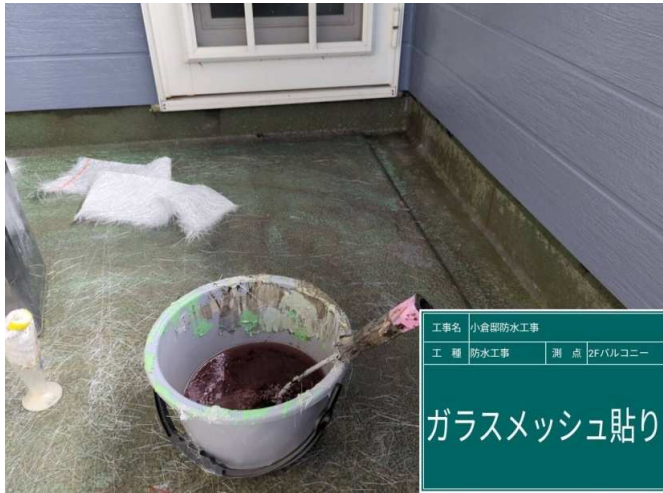
37 防水 ガラスメッシュ貼り 施工中
