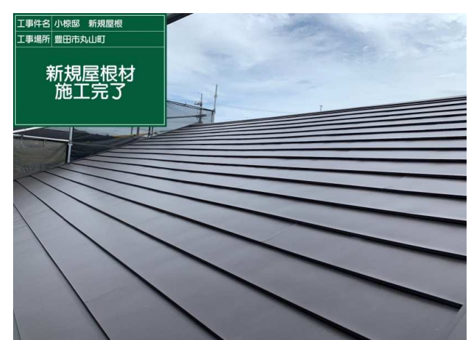
48 横暖ルーフ S貼り 施工完了
