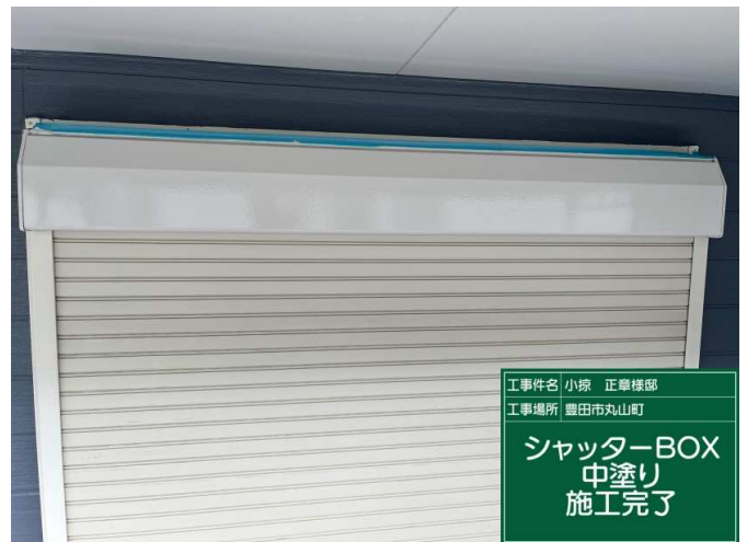
32 シャッターBOX 中塗り 施工完了
